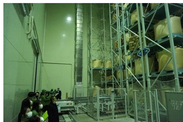
自動で出荷、取り出しができる米倉庫
